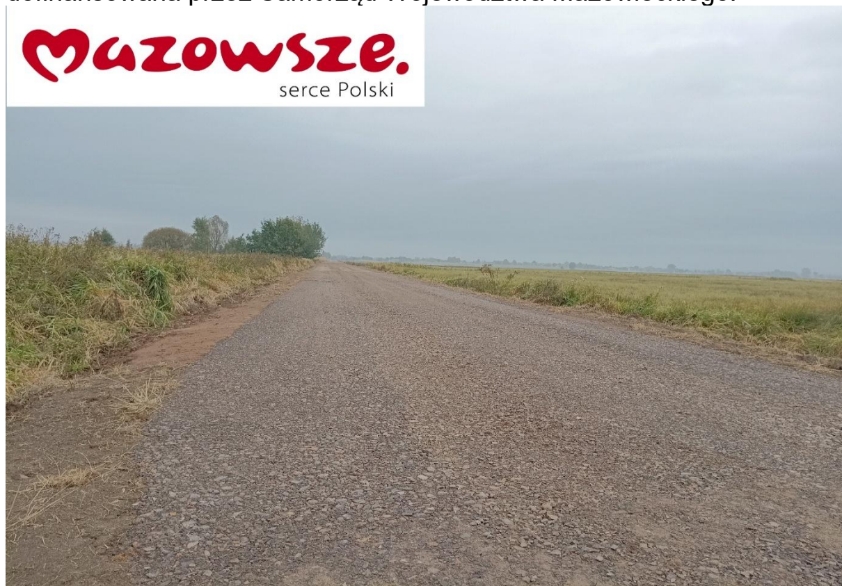
Jeden z przebudowanych odcinków dróg w Mirowie Starym.
